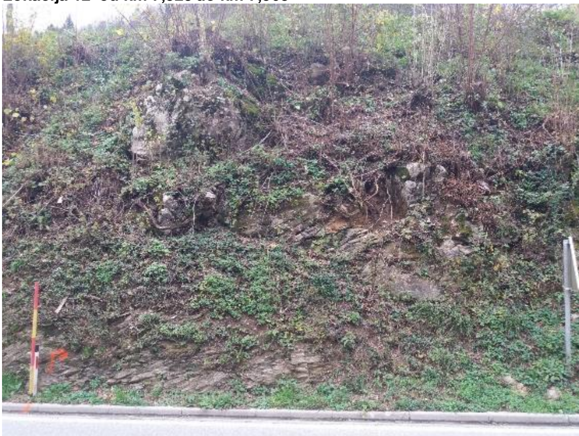
Lokacija 12 od km 7,523 do km 7,563
