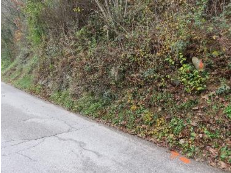
Lokacija 11 od km2,225 do km2,255
