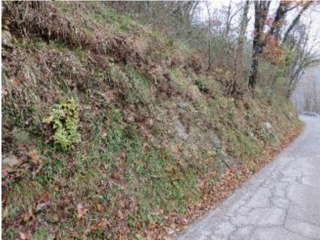
Lokacija 5 od km1,649 do km1,680
