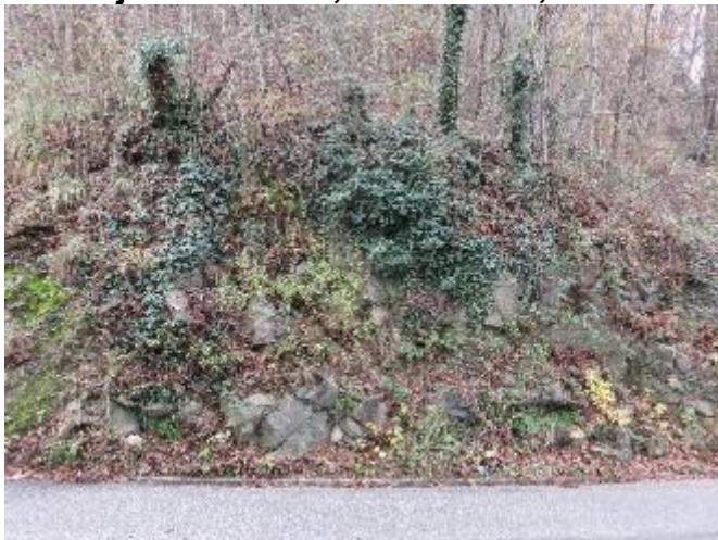
Lokacija 1 od km1,095 do km1,112
