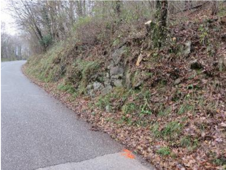
Lokacija 8 od km1,827 do km1,828
