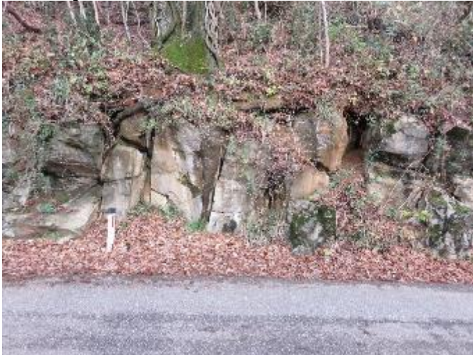
Lokacija 16 od km3,158 do km3,184
