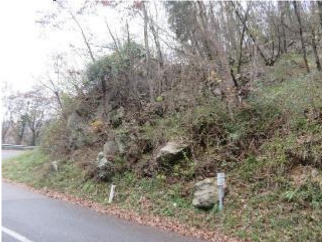
Lokacija 20 od km3,507 do km3,514
