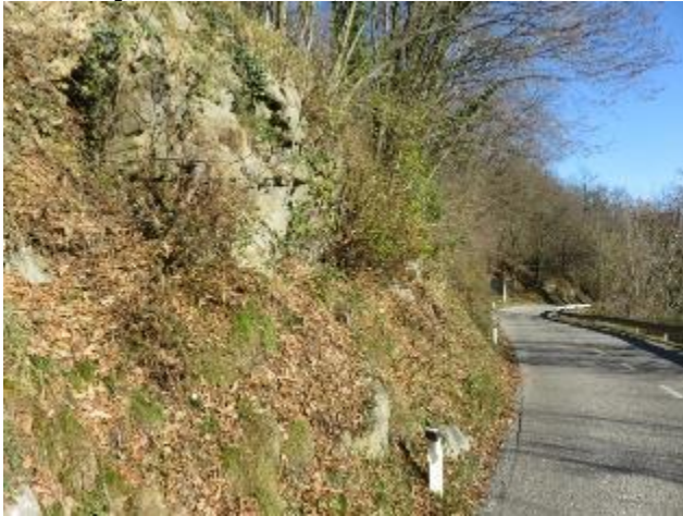
Lokacija 23 od km3,580 do km3,604
