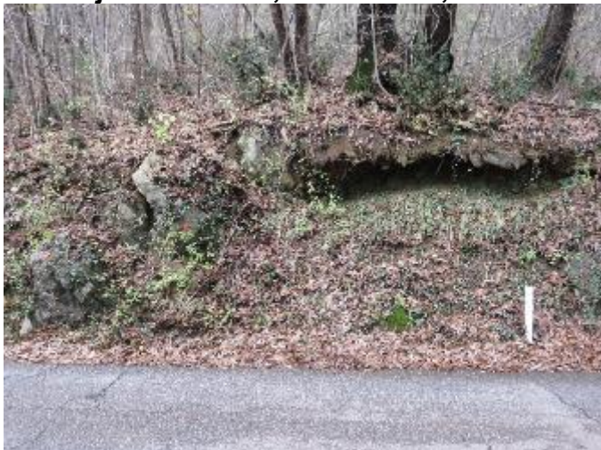
Lokacija 13 od km2,578 do km2,612
